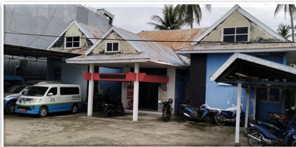
Gambar 1.2. Gedung/Kantor Dinas P2KBP3A
